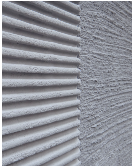
Kammputz auf WDVS, Hofstatt München, Meili, Peter Architekten, 2013.
