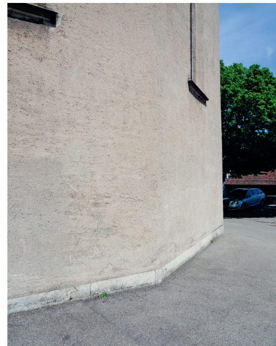
Die Putzfassade der Stadtkirche Baden diente als Referenz. (Bild: Meier Leder Architekten, Baden)
